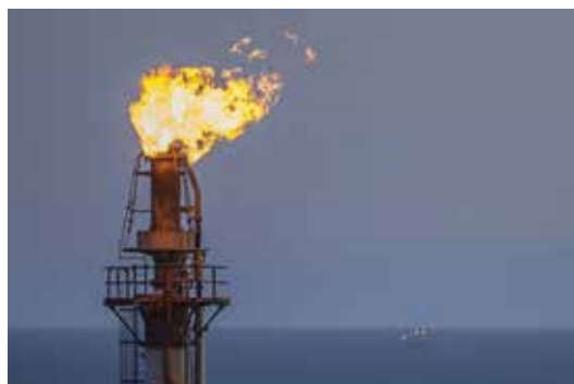
Altona Refinery Flare
